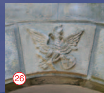
26 Portal des Liethstollens
